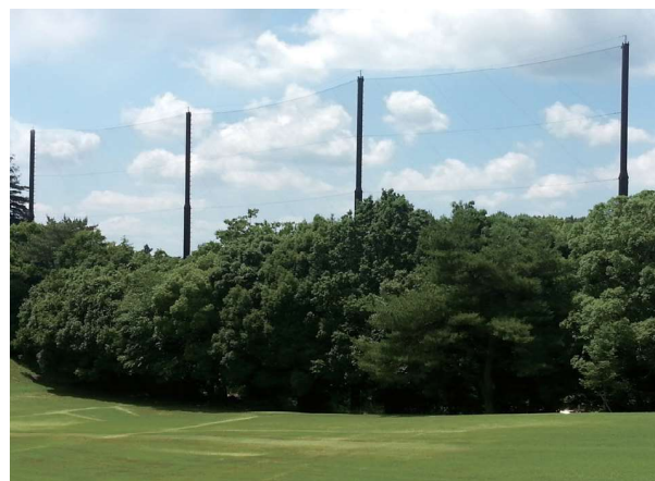
987 防球ネット (1) ボール S-JOY:現在最も使われている最新式のジョイント型炭素鋼銅管 (2) ネット ペクトランネット:最新のスーパー繊維合成樹脂 ペクトラン製
